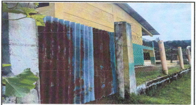
Foto 4: Sustitucion de Puertas de Metal
