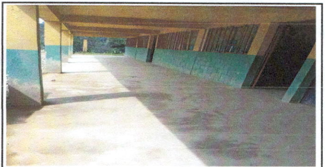
Foto 6: Sustitucion de Piso por piso de Granito
