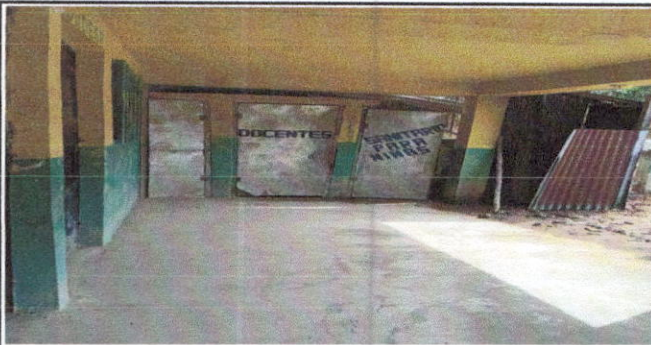
Foto 5: Sustitucion de Puerta de metal de Baños
