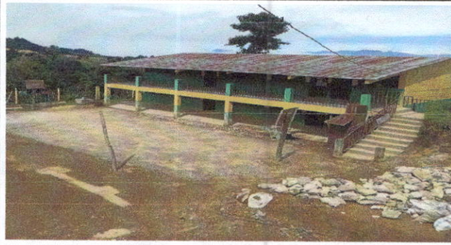
Foto 1: Cambio de techo por lamina troquelada aluzinc calibre 26
