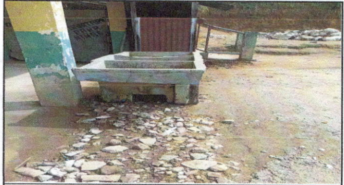
Foto 2: Sustitucion de Piso de torta de concreto
